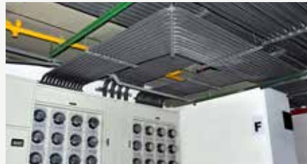
電導管工程 Electrical engineering
