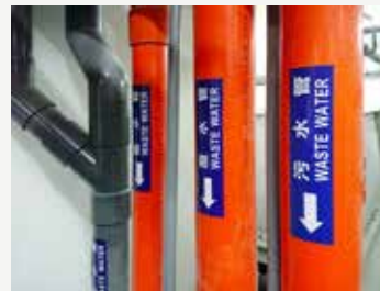
下水道工程 Sewer Engineering
